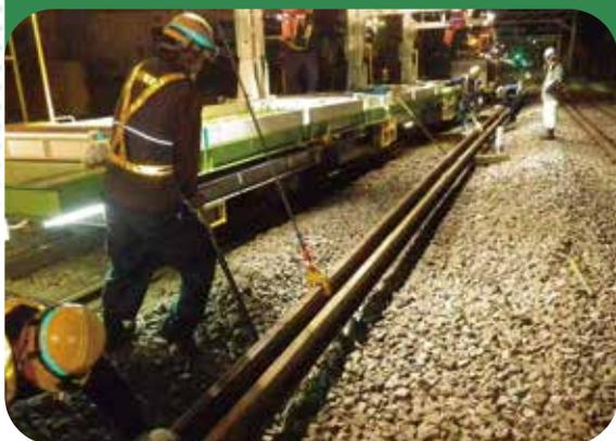
工事に使用する分材やレールをMCといわれる特殊な車両に積み込み、指定された駅構内や駅間に移動して、積み下ろしをする作業です。
