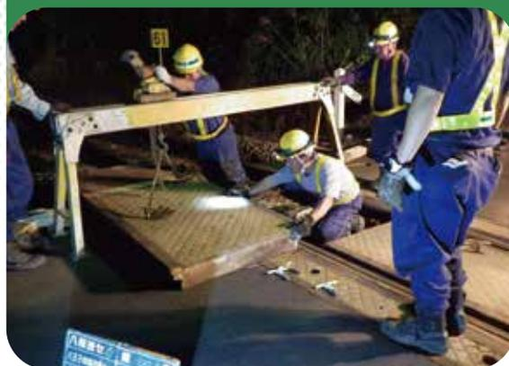
踏切の一時撤去をして、レールの高低調整(ジャッキを使用)を行います。その後、砂利を専用の電気機器で突固めして、復旧する作業です。
