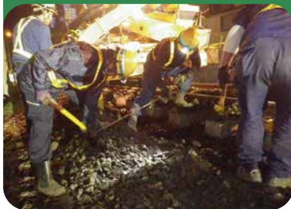
線路下、線路脇の道床(砂利)の入れ替えを行う作業です。重機械や特殊な車両を使用して行う施工も多く、施工方法は施工箇所により様々です。入れ替え後は崩れないようにコンパクターなどで道床の締固めを行います。
